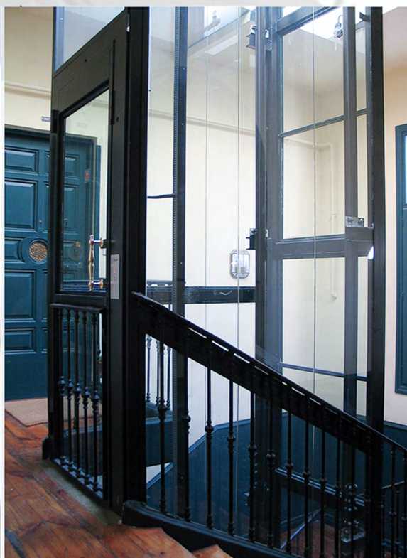
EJEMPLO DE ASCENSOR COLOCADO EN EL HUECO DE LA ESCALERA
